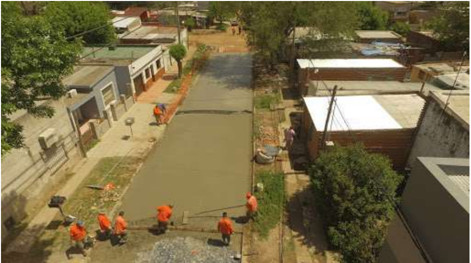
Imágenes de pavimento en los barrios
