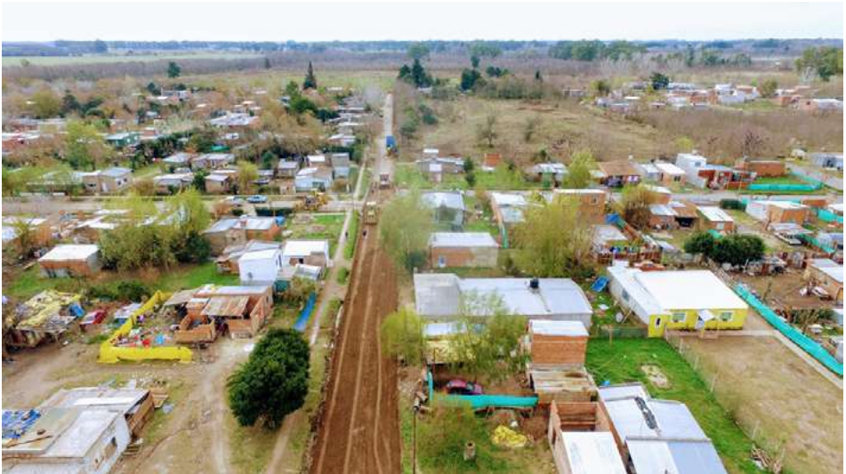
Imágenes de la obra en calle 61
