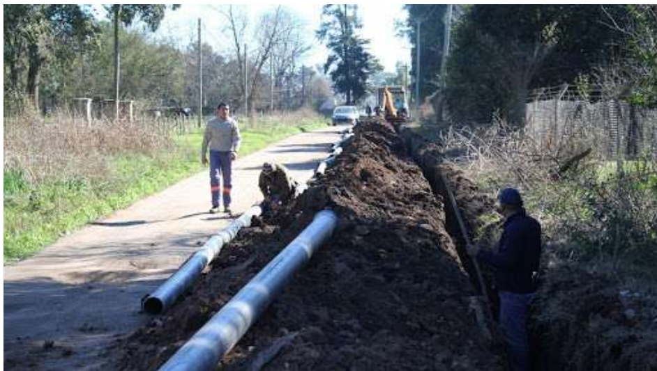
Imágenes de obras de extensión de red cloacal
