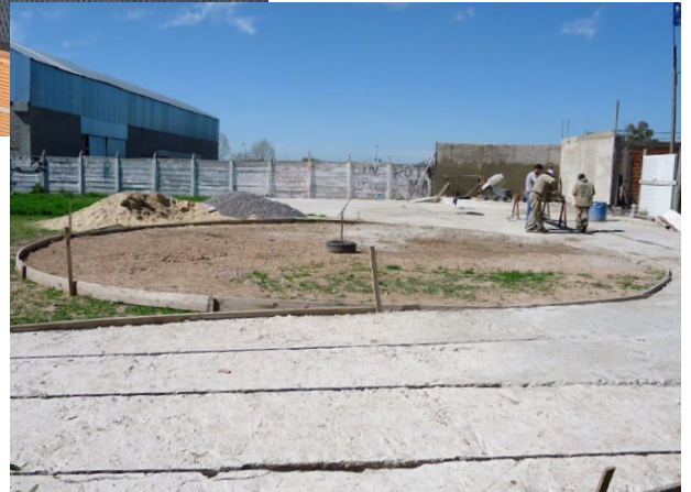
Programa para la Mejora del Hábitat - Subsidio a las organizaciones de la comunidad. Cooperativa Pacha Limpia Ltda. Obra: construcción de plaza y salón de usos múltiples. Berazategui.
