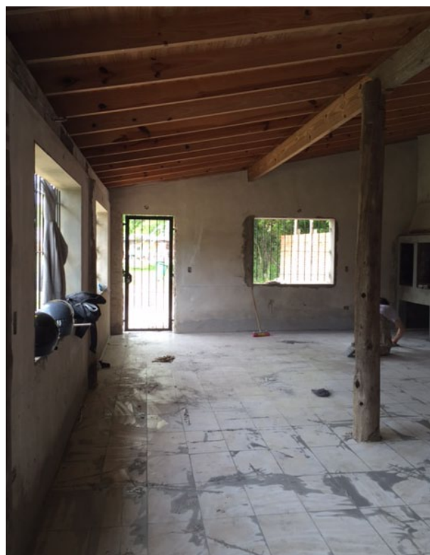
Programa para la Mejora del Hábitat - Subsidio a las organizaciones de la comunidad. Club Social, Deportivo y Biblioteca Popular Corazones de El Retiro. Obra: playón deportivo y edificio soporte de actividades recreativas y sociales. Barrio El Retiro, La Plata.
