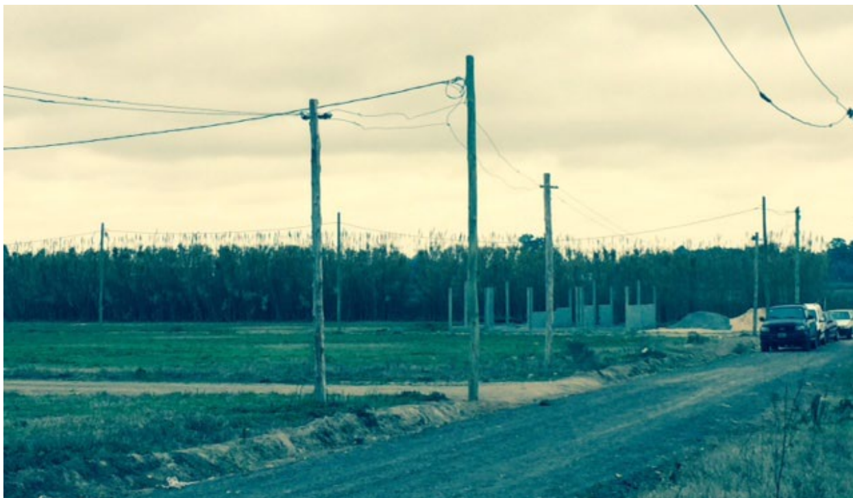
Programa para la Mejora del Hábitat - Subsidio a las organizaciones de la comunidad. Cooperativa de Trabajo Movimiento Evita N° 1. Obra: Red aérea trenzada de baja tensión. Barrio Néstor Kirchner, Virrey del Pino, La Matanza.
