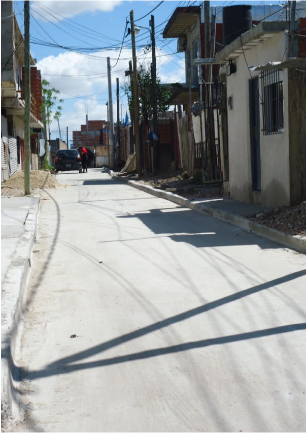
Programa de financiamiento para infraestructura de redes públicas domiciliarias e intradomiciliarias de servicios básicos, obras complementarias y/o equipamiento comunitario. Obra: Pavimentación Barrio Nueva Ana. Avellaneda.
